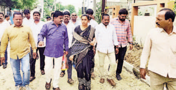
సిసి రోడ్డు పనులు పరిశీలిస్తున్న కార్పొరేటర్ ఎం.రజజిరెడ్డి తదితరులు
